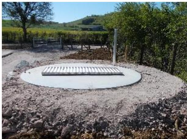
**Ouvrage de chasse Ø 2000 à 3600 avec trappe d'accès couverte par capotage aluminium**
