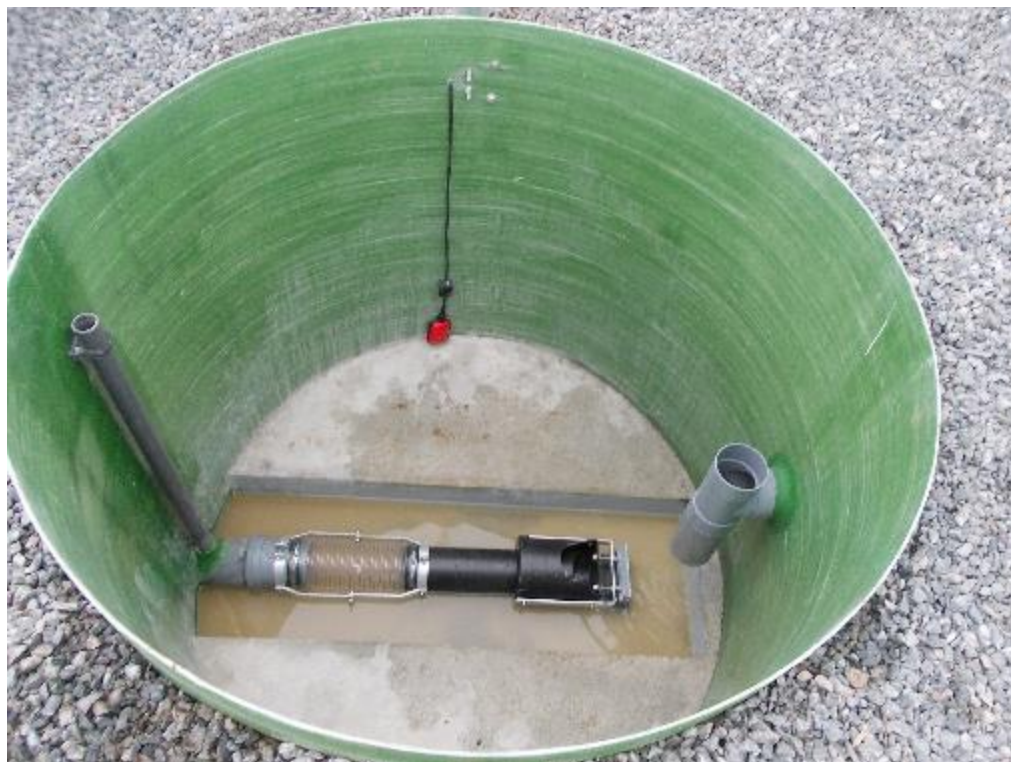
Chasse Ø 1500 à clapet (hauteur 1,10m), volume maximum 900 litres. Trappe d'accès Ø 1500 en polyester (capot fermé)
