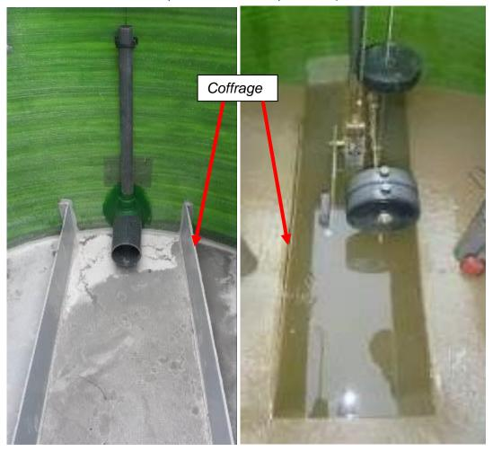
Le fond de l'ouvrage de chasse est à aménager par l'installateur une fois l'ouvrage mis en place sur le terrain. La réalisation d'une forme en béton optimise l'auto-curage et limite les eaux stagnantes, avec la création d'une cunette de dimensions adaptées au fonctionnement du mobile de chasse.
