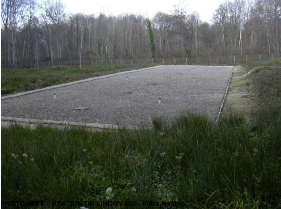
PHOTO **ABT** - STATION DE LINDRY (89) - Filtre à sable
