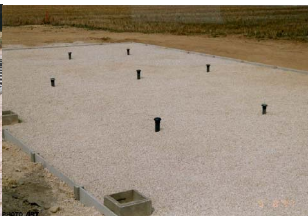
FILTRE A SABLE – Couverture de graviers
