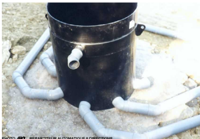
Raccordement d'un répartiteur automatique 8 voies
