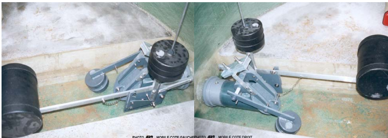
CHASSE A CLAPET – Dispositif de verrouillage
