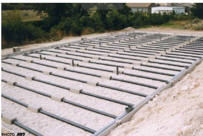
FILTRE A SABLE – Pose des drains d'alimentation
