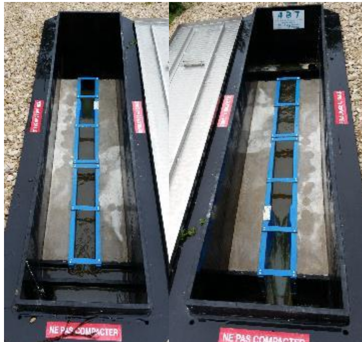
Canal venturi TYPE II Coté entrée – coté sortie
